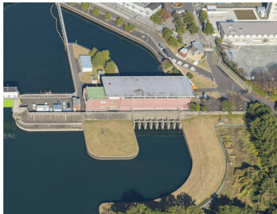
～辰巳排水機場～
