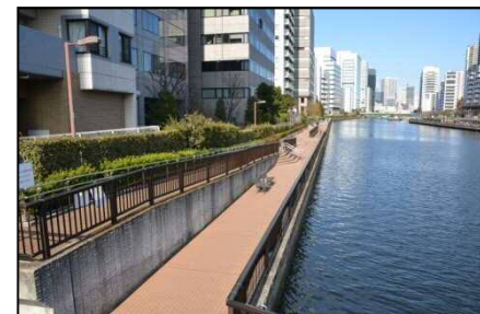
内部護岸（高浜運河）
