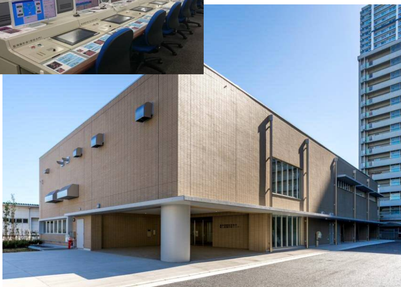
～第二高潮対策センター外観～
