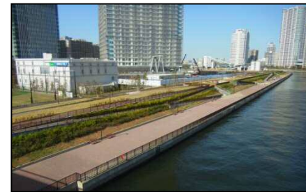
防潮堤（晴海二丁目）
