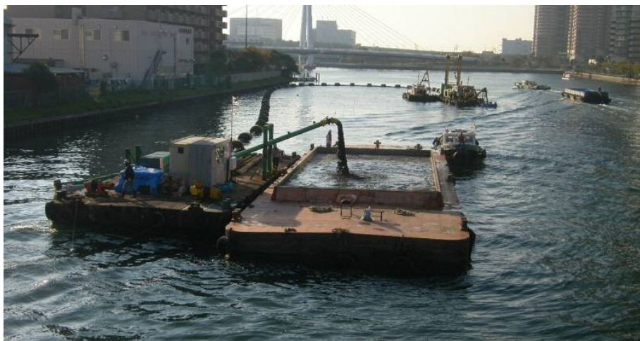
～汚泥しゅんせつ状況～
